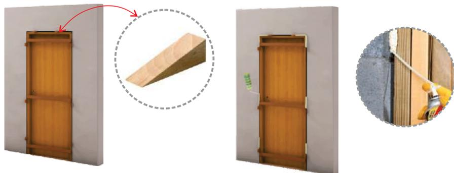
**4.5.** Depois de 24 h, deve se retirar as travas e os espaçadores, para verificar seu funcionamento, basta abrir e fechar a porta diversas vezes. Retirar as cunhas e cortar o excesso de espuma com estilete. Realizar os cortes com Serra meia esquadria em ângulo 90° ou 45°. Posteriormente proceder a aplicação dos alisares com cola nos rasgos dos batentes.
